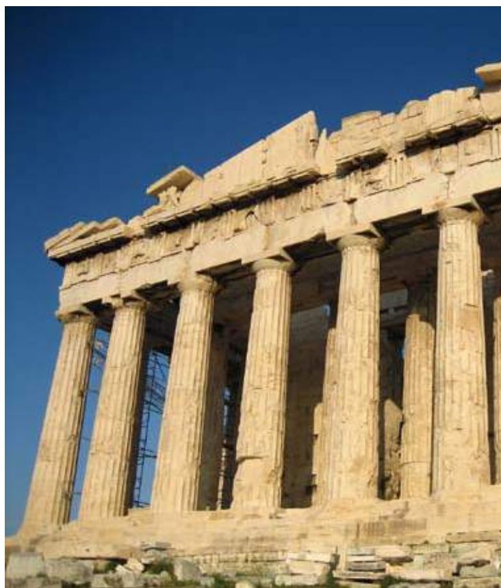
Парфенон. Вид с запада. Колонны дорического ордера
